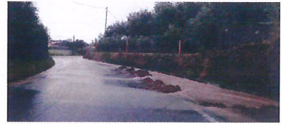
Via Pastrengo, la Sp31b, nei pressi di Lazise. Leggeri smottamenti hanno portato terra sulla carreggiata
